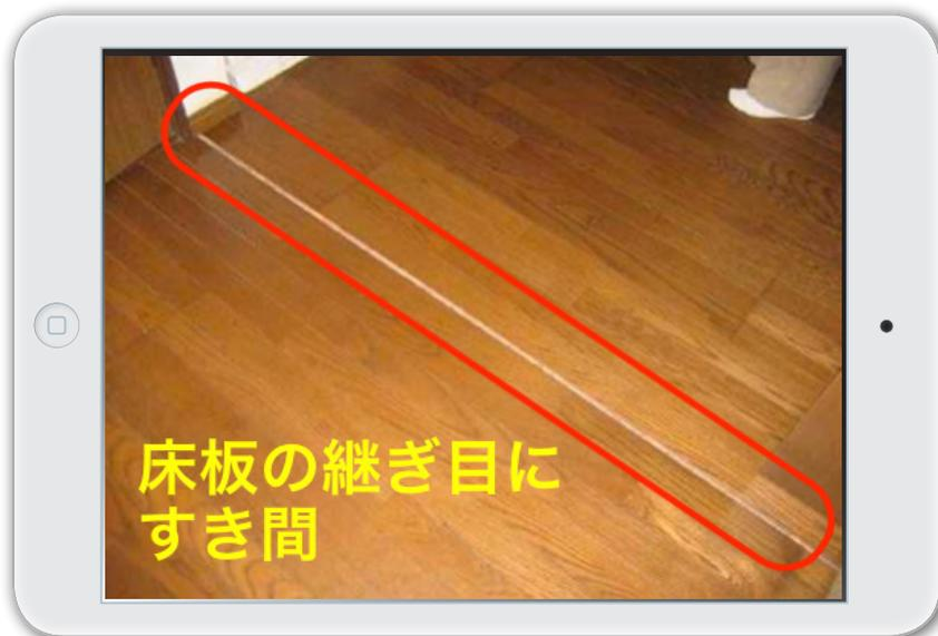
図 23 床被害写真の例\*注
