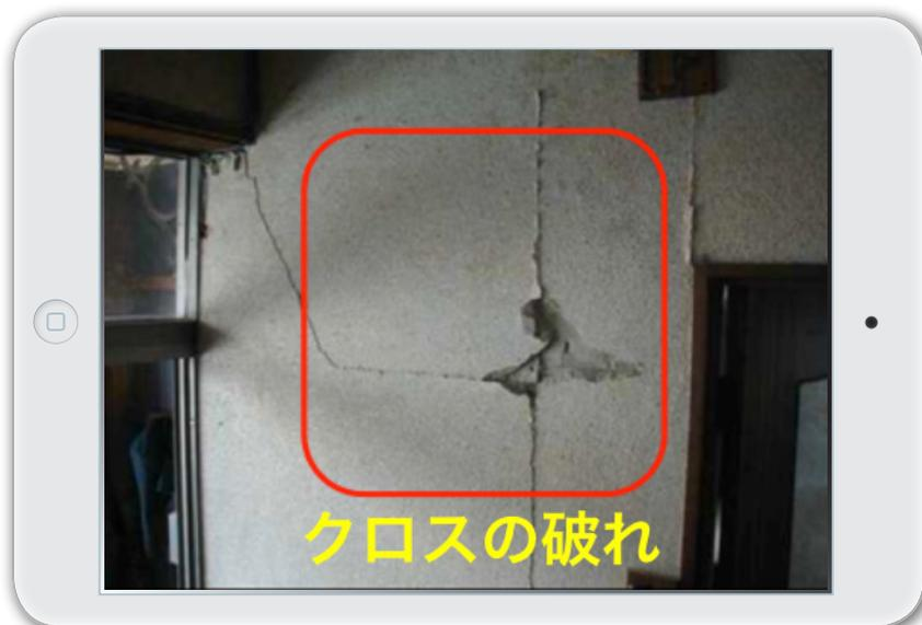
図 19 内壁被害写真の例 \*注
