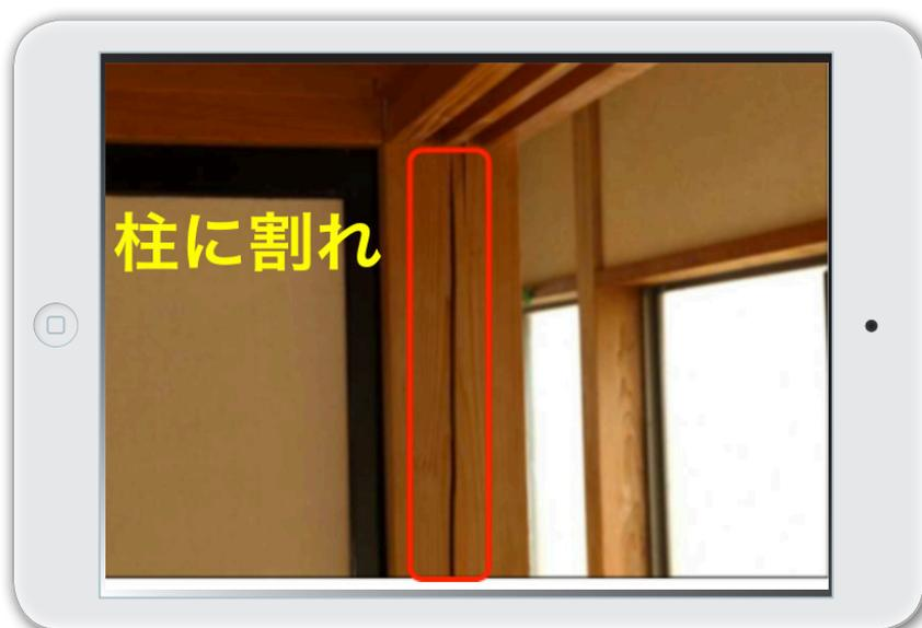
図 21 柱被害写真の例 \*注
