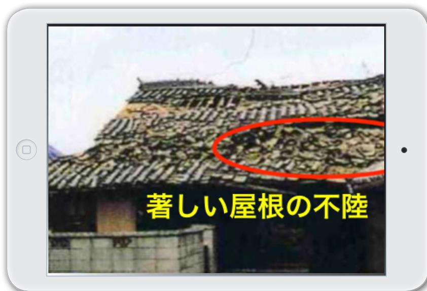
図 10 屋根被害写真の例\*注
