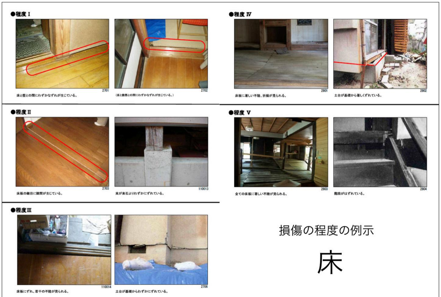
図 30 床の損傷の例示 \*注
