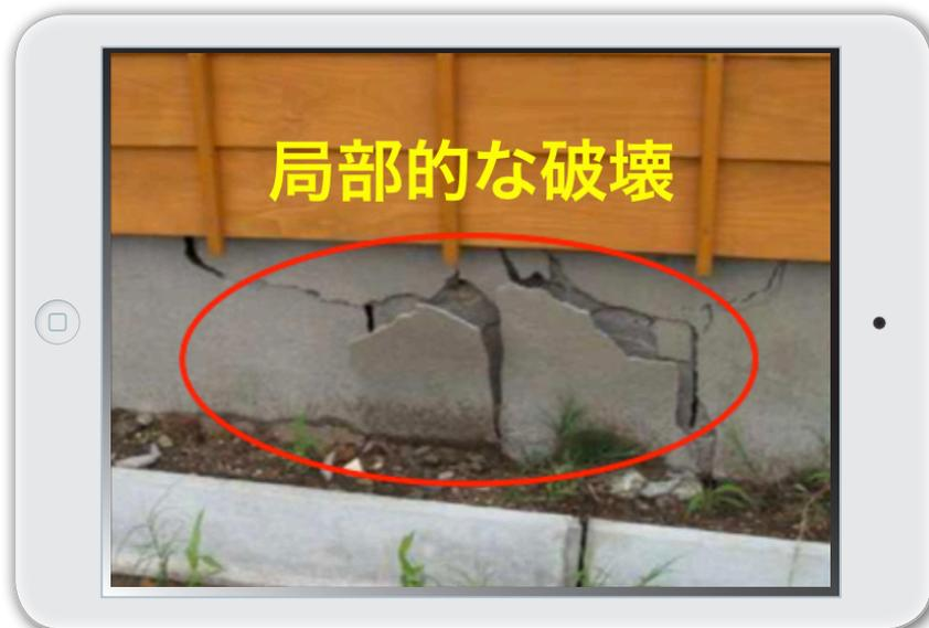
図 15 基礎被害写真の例 \*注
